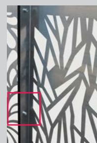
Plis latéraux avec 3 trous pour liaison avec le poteau
